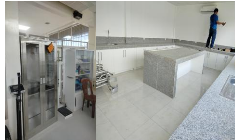
MANTENIMIENTO Y REPARACIONES COLONCHE
